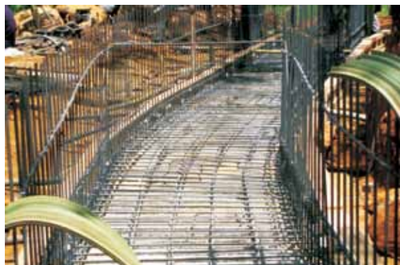
Canal Construction for Gammaduwa Mini Hidro Power Project
